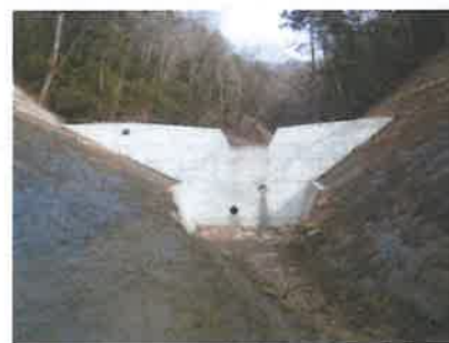
【治山ダムの整備】
