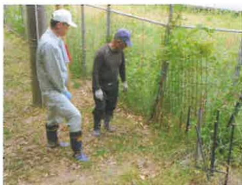
【侵入防止柵の点検】
