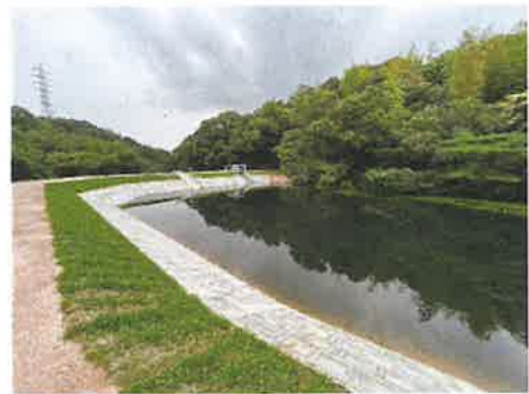
【ため池の改修】
