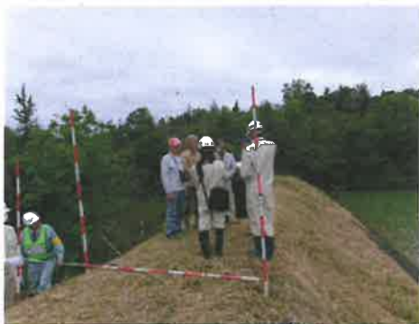
【ため池点検パトロール】
