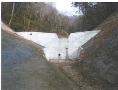
【治山ダムの整備】
