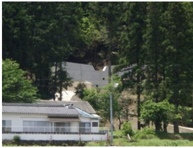
治山ダムの整備
