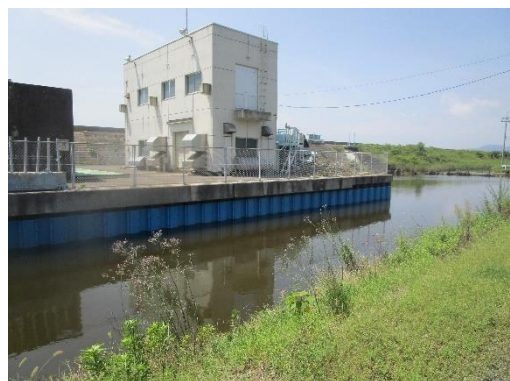
水利施設の整備
