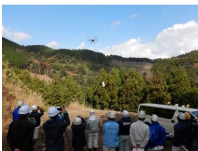
ドローンによる資材運搬
