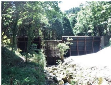
鋼製堰堤の長寿命化
