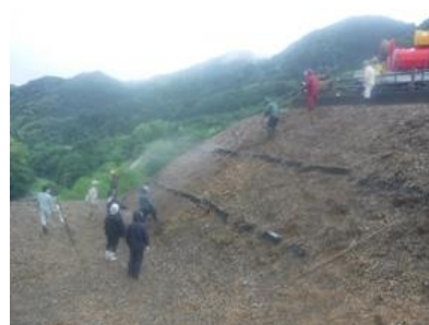
水田法面のセンチ ピードグラス吹付
