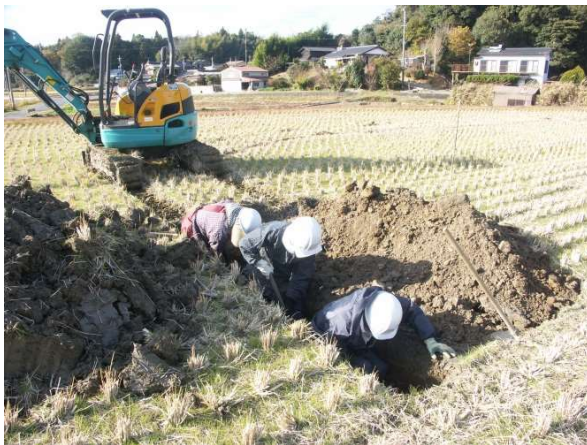
人力掘削の様子
