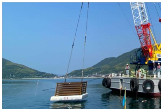
魚礁設置状況（周南市）
