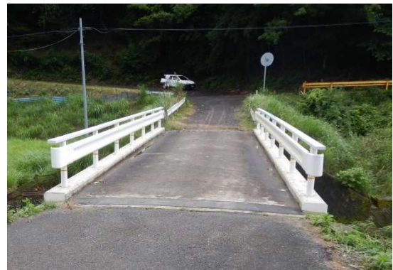
林道橋の補修 (下関市：琵琶の甲線)
