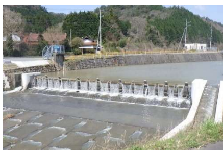
頭首工の改修 (山口市：吉部野地区)
