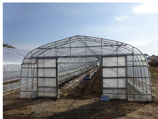
遊休施設の改修実証（宇部市）
