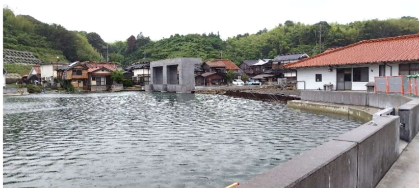
海岸保全施設（水門工）の整備（江崎漁港海岸）
