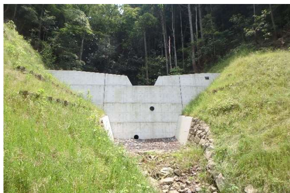
治山ダムの整備 (阿武町：松柄地区)
