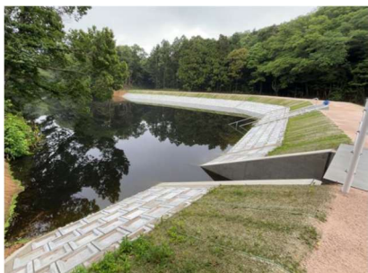
ため池の改修 (防府市：名舟ため池)
