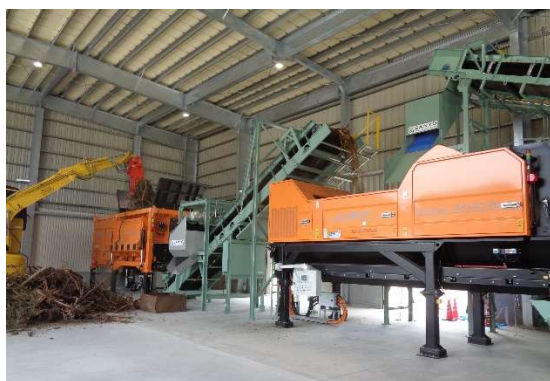
木質チップ加工施設の整備（岩国市）
