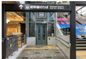
1F→2Fひかり広場口 エレベーター
