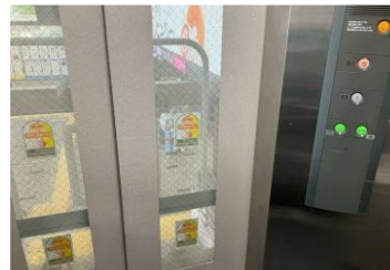
エレベーター内
