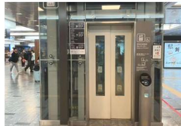
2F新幹線ひかり広場口から3 F13・14のりばホームへ エレベーター
