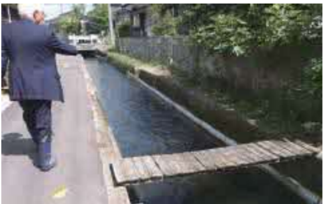
白いFRP(繊維強化プラスチック)板が水路の表面に貼られている。平成16~20年に施工。水路の両側に貼ることで抵抗値を減らし、下流まで行き届かせる対策
