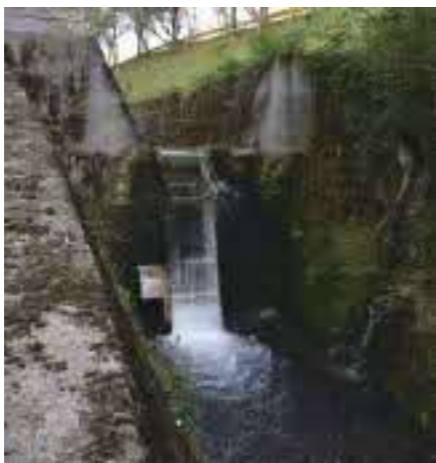
小水力発電は、旧向峠小学校（現在、通信制の松陰高校）の東側にある10号分水口から最後、深谷川へと落ちる水で行われている。月に2万5〜7千円ほどを中国電力に売電している
