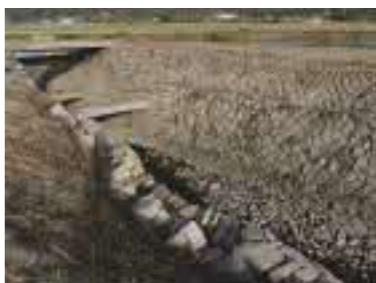
榎野川寄り(西)から堤防を歩き始めると、まず三挺樋があった。古い絵図からかつては樋守小屋もこの堤防の東にあったことがわかっている
