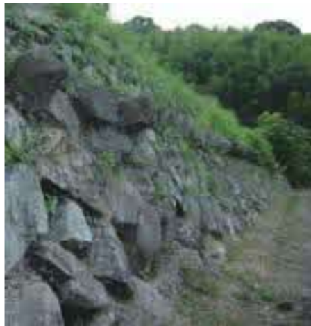
石積み技術は巧妙で、法面を歩くための足場が見事に組み込まれている
