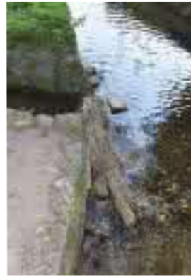
井手川(水路)の分水地点にある「やた」。細い笹を束にして、かずらで縛る。これで水路を塞いで水量を調整する。一ノ井手川(写真中心)の幅は、約1.5m、二ノ井手川は50cmの幅だそう
