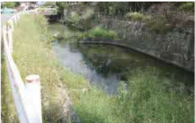
水路は工夫に満ちている。わざと水の流れを変えて、「砂溜め」(水流を緩やかにして泥を沈殿させる)を設けた箇所。水路幅を2倍にすることで流速は2分の1になる
