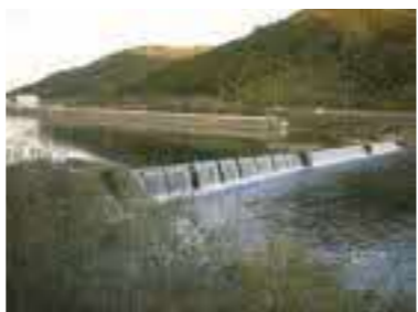
取水は榎野川上流にある淋洗井堰(りんこういせき)から。寛永・万治年間(1640~1660)に築造。川の東側(写真では向こう岸・左岸)に、名田島へ流れる用水路がある。右岸側は小郡を潤す
