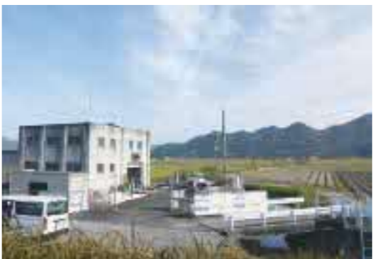
写真左手の建屋は、名田島地区にある排水機場の一つ。「干拓地の命は、排水」。浅原さんが言う。満潮時は海拔0m以下になる。今は土地改良事業のおかげで排水ができ、大豆栽培も可能に
