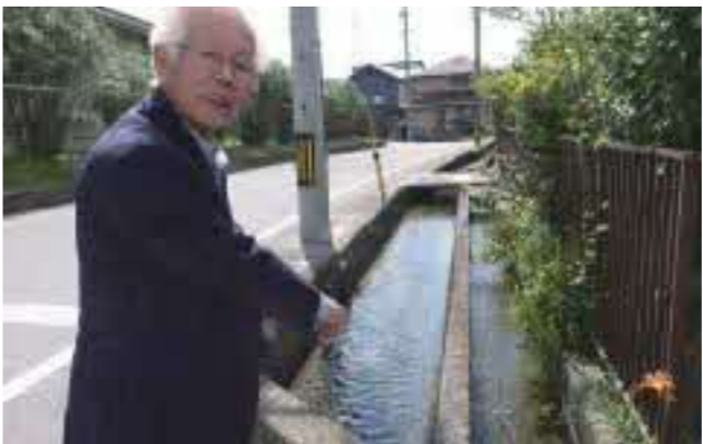
用水路は水系ごとにあり、水系が違う2本の水路が並ぶ場所も。水路の高さもスピードも違う。防府土地改良区の属理事長が説明してくれる
