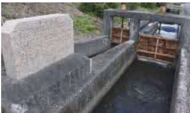
昭和43(1968)年にできた寝太郎用分水工。石板には分水協定が彫られている。幅の太いほうが、東幹線へと流れていく。現在は西幹線のほうが耕作面積は広いが、全体に耕作地が減ってしまったため、この分水幅のままで足りているのだそう
