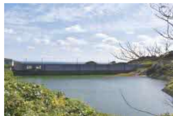
見島ダム。2002年に完成した、主に上水道・治水を目的としたダム。総貯水量12.5万㎡。堤高31m、堤頂長300m。レアなダムカードは人気がある
