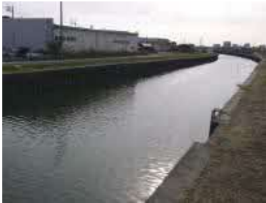
開作地の重要な排水河川、中川
