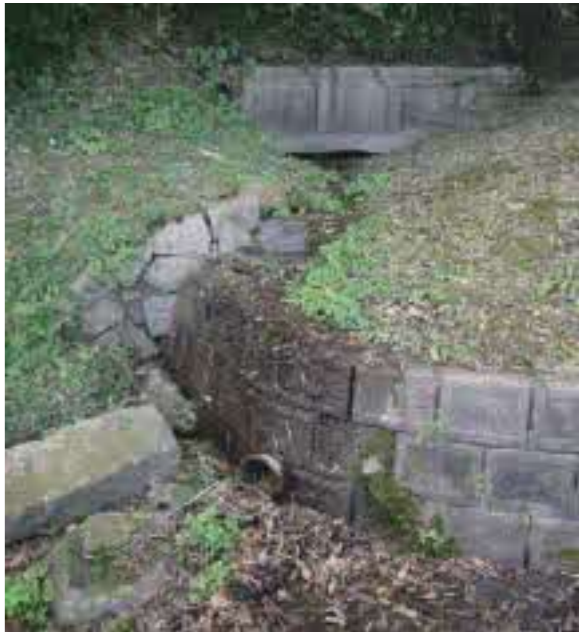
辰の口隧道。もともと半島であった岩盤をくり抜いた。長さ150メートル。高さ1.9メートル、幅3.7メートルもある立派な隧道だ。昭和隧道ができるまでの、1821(文政4)年~1933(昭和8)年の112年間使われた
