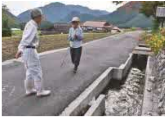
水路の沿道は約3mの幅がある。消防のポンプ車が通れることを考えての道幅。水路沿いを散歩する89歳になるという散歩中の女性に出会う。ちなみに、分水口の6号と7号の距離は近く、50mほど
