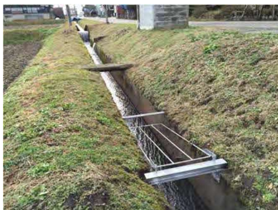
救助用スクリーンの設置
