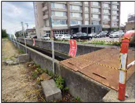
応急ロープの設置
