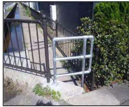
侵入防止柵を設置 (新潟県新潟市)
