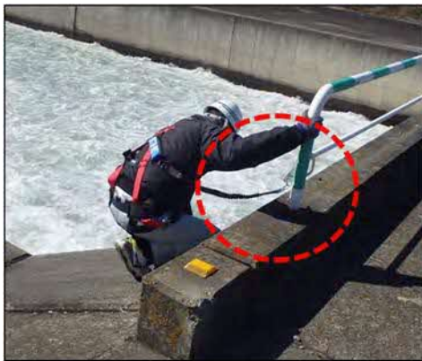
安全带を使用し水路への転落を防止
