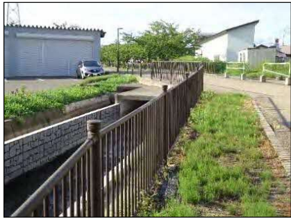
遊歩道沿いに安全防護柵の設置 (秋田県横手市)
