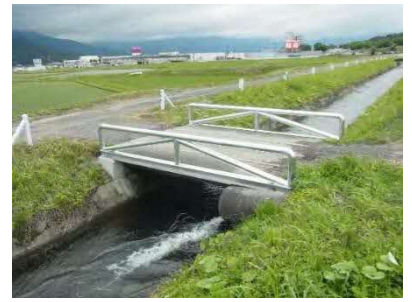
床板橋に転落防止柵を設置 (新潟県南魚沼市)
