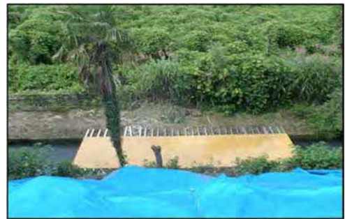
水路への仮蓋の設置
