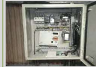
監視装置の設置
