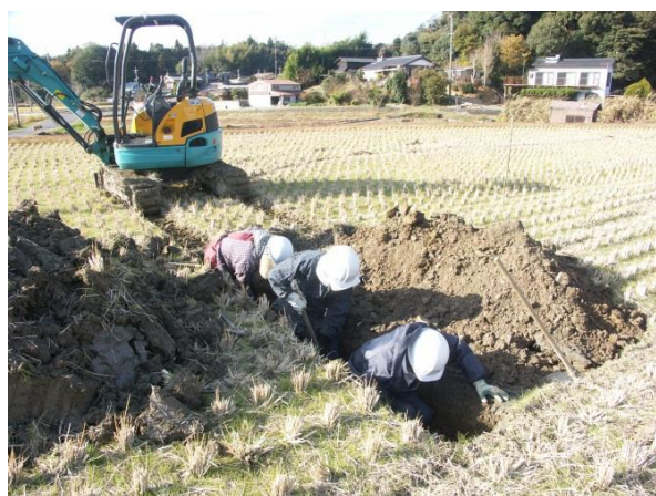
人力掘削の様子
