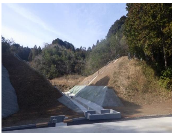
(堤体切開によるため池廃止)
