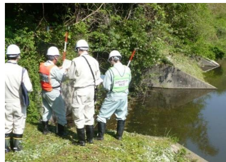
（ため池点検パトロールの様子）
