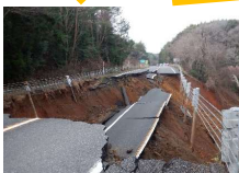
道路啓開・災害復旧
