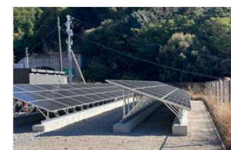
太陽光発電施設の設置
