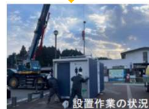
設置作業の状況
