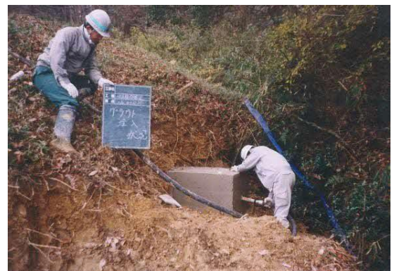
モルタルグラウト注入（下流側）
