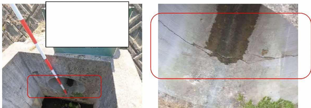
写真-3.5.3.2 底樋管と土砂吐等との接続部
