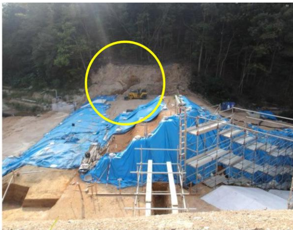
袖部取り付け事例（遠景）
