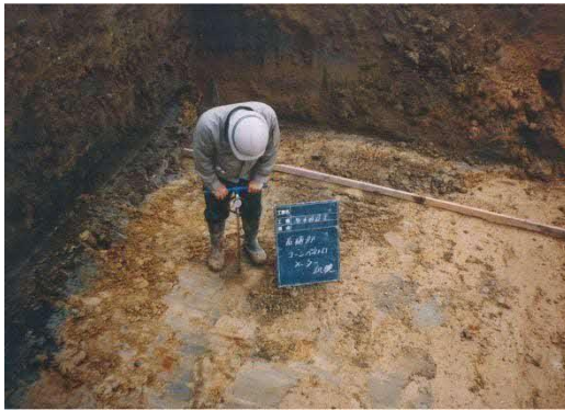
基礎地盤支持力確認
