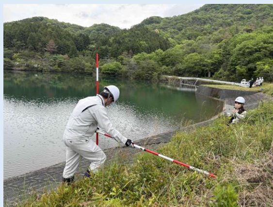
タブレットを活用した調査点検
